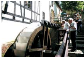
Wassermühle in Krosigk
